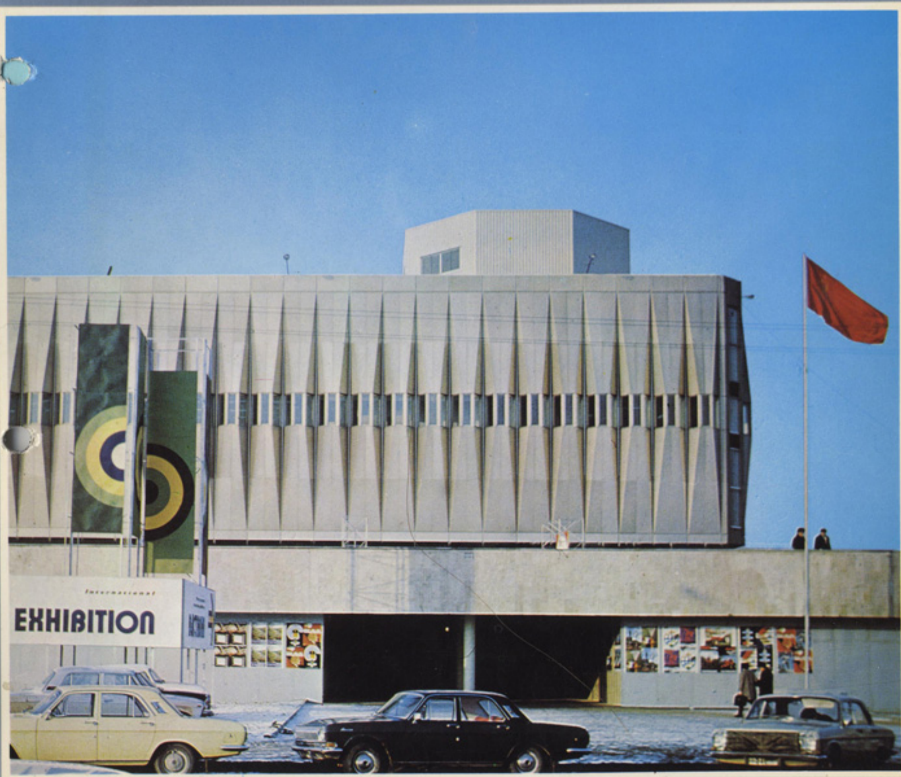
Павильон № 1 выставочного комплекса, строящегося на Красной Пресне в Москве.
